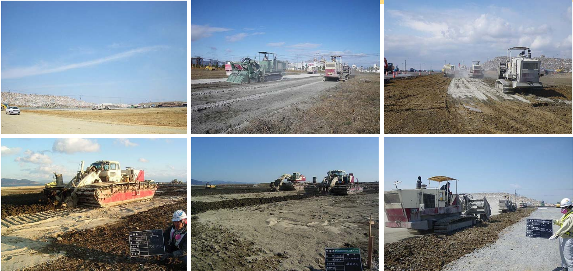
建設用地の遠景と路床安定処理施工状況
