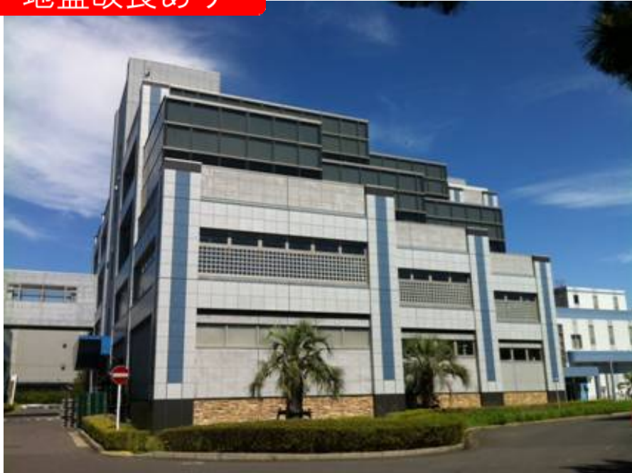
対策を施した再資源化施設
