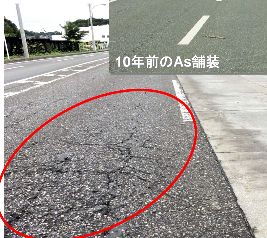
隣接のアスファルト舗装部 (わだち掘れ等の著しい損傷)
