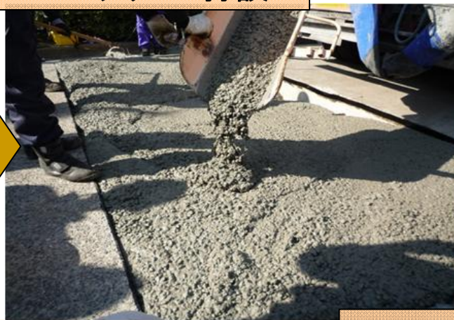
コンクリート打設
