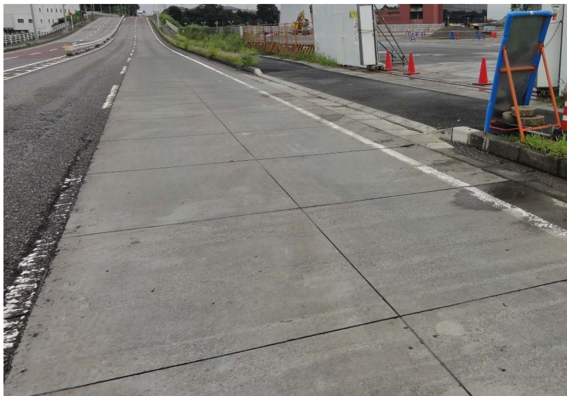
ホワイトトッピング工法舗装 (ひび割れは認められない)
