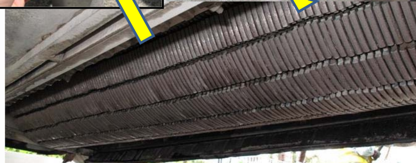
スペーサを挟んだダイヤモンドブレードでコンクリート表面を切削する
