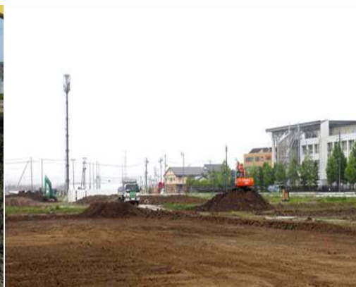
スタビライザによる安定処理工
