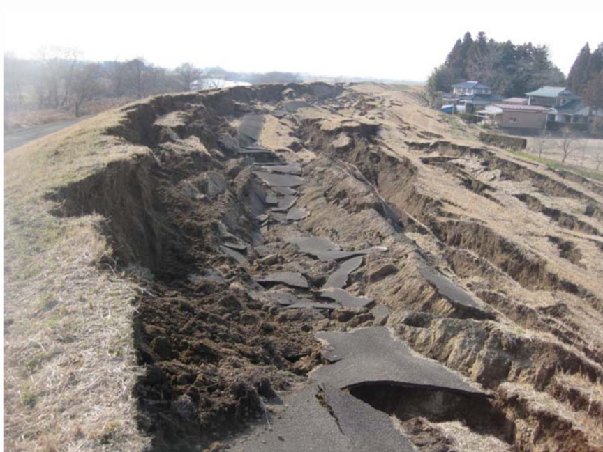
鳴瀬川堤防の被害状況
