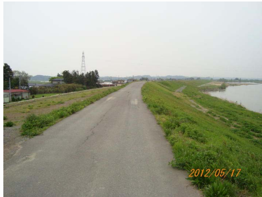
2003年に本復旧工事がなされた現場（被害なし）
