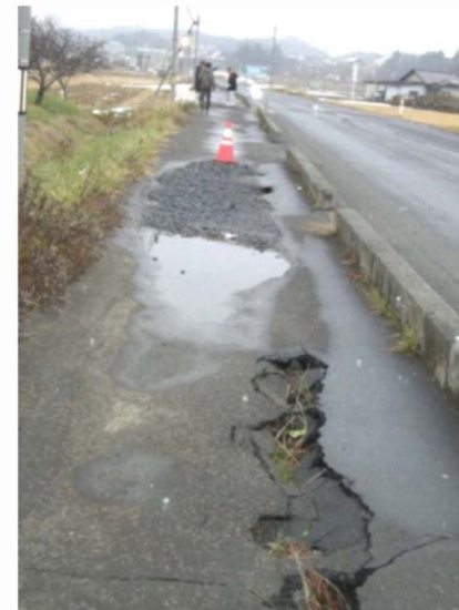
液状化未対策施工
