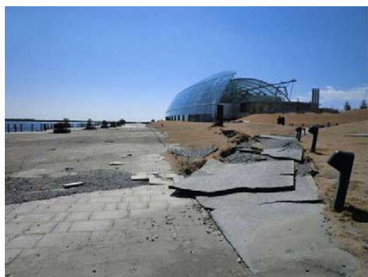
地盤改良していない建物周辺の被害
