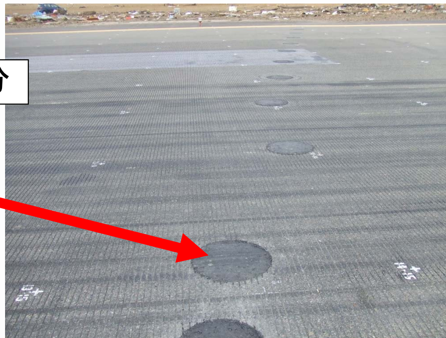
地盤改良を施した誘導路部の地震後の状況
