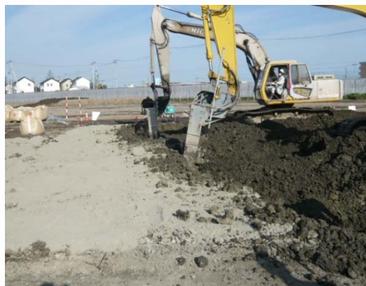
スタビライザによる安定処理工
