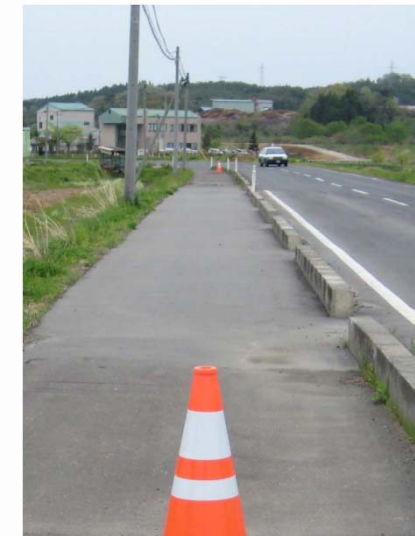
液状化対策施工
