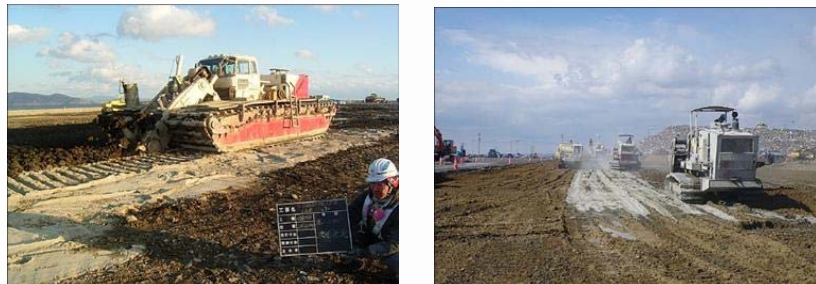
スタビライザによる施工状況
