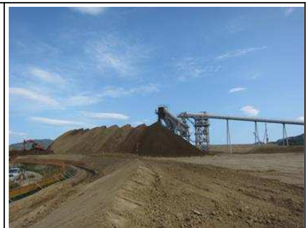
土砂運搬の状況
