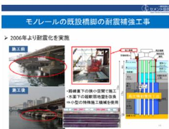
東京モノレールは、2006年より順次構造物の耐震化が進められています。海上部に位置する既設の橋脚は運河のなかに位置し、水深は約4m、海底面から固い地盤の層までの深度が約17mであり、海底面付近には特に軟弱な層が堆積しています。この橋脚の支柱は、基礎部から補強する必要があることが判明し、支柱の周囲をぐるりと囲んでセメント系固化材で固める耐震補強を実施しました。モノレールの軌道直下で施工するため高さ制限は3mと低く、狭小現場でも地盤改良できる特殊な施工機械が用いられました。施工中は常時、モノレールの軌道が監視されましたが、施工による変形は生じず、モノレールの運行に影響を及ぼすことはありませんでした。また、大型機械を必要としない工法の採用により、狭小な場所での施工性が可能であることが確認されました。
