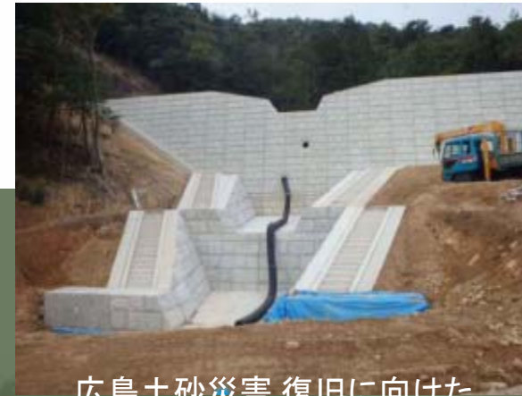
広島土砂災害 復旧に向けた 国土交通省の取組みより引用
