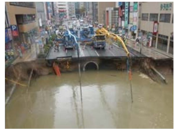
流動化処理土の埋戻し
