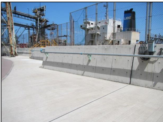
防潮堤の設置 (三菱マテリアル(株) 九州工場)
