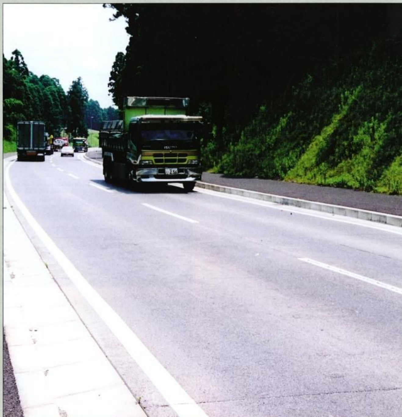
千葉県道・栗源町付近のポーラスコンクリート舗装
