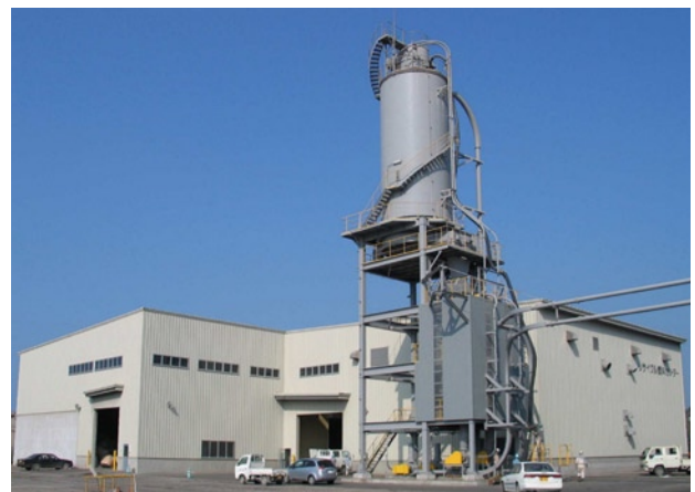
写真3 廃プラスチック処理設備
