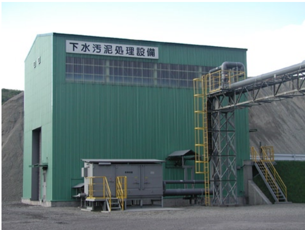
写真4 下水汚泥処理設備
