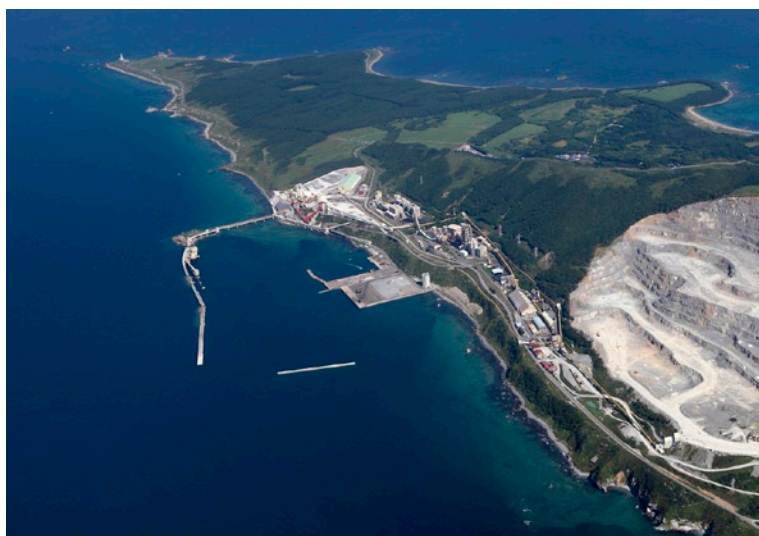
写真1 海岸沿いに建つ青森工場の全景
