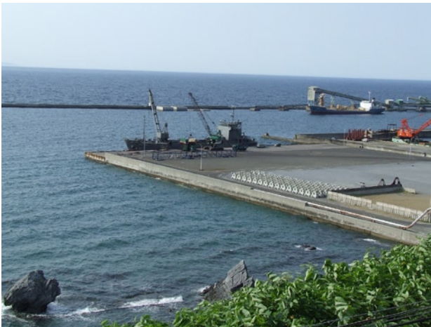
写真3 尻屋崎港での受け入れ状況
