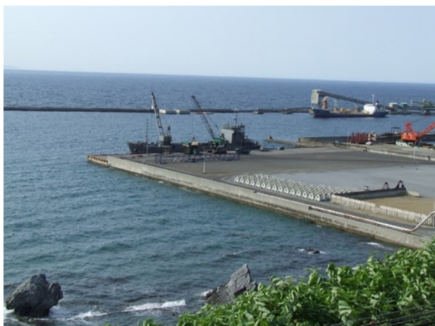
写真3 尻屋崎港での受け入れ状況
