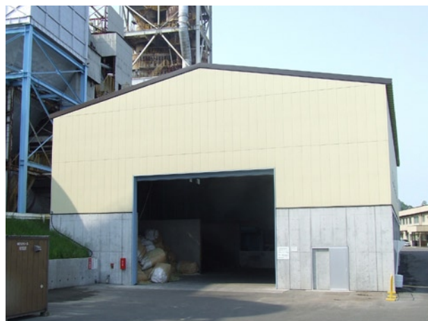
写真4 廃棄物受け入れ施設
