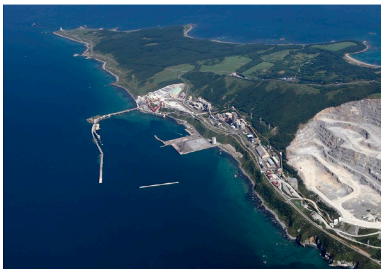
写真1 海岸沿いに建つ青森工場の全景
