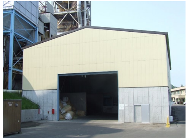
写真4 廃棄物受け入れ施設
