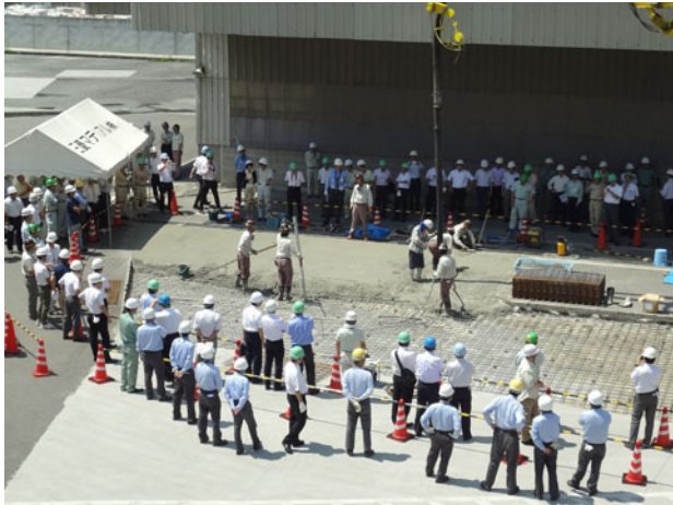
写真5 大勢の見学者が集まった1 DAY PAVEの施工
