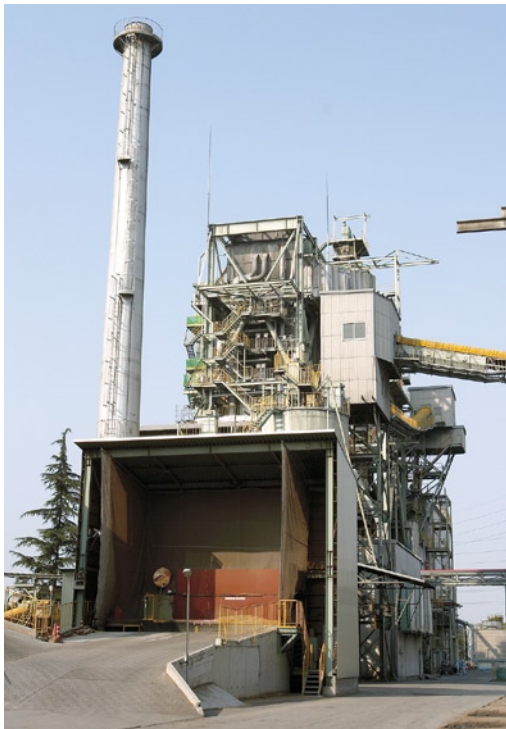
写真2 自家発電装置(奥)と木くず投入設備
