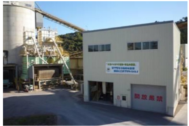
写真4 木質チップ破砕機&投入設備
