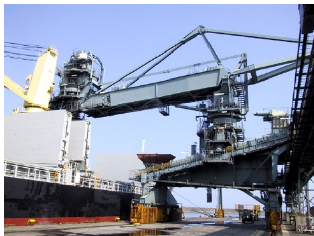
写真4 連続式アンローダによる姫川港での荷揚げ
