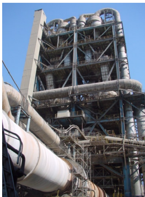
写真2 SCS式プレヒーター
