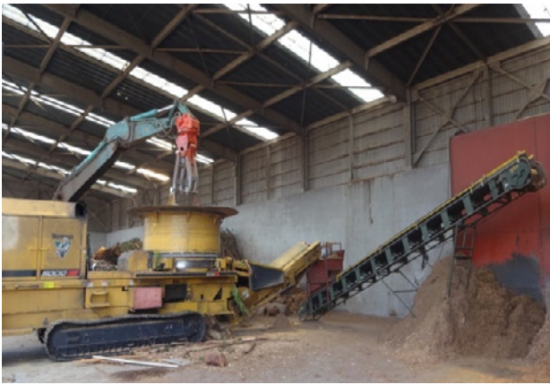
写真8 間伐材破碎設備
