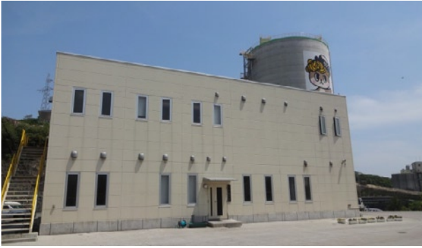
写真4 高台に移設された中央操作室
