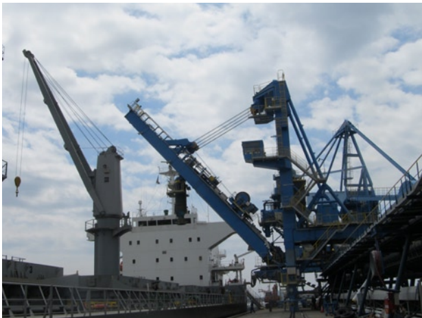
写真4 クリンカー積込設備
