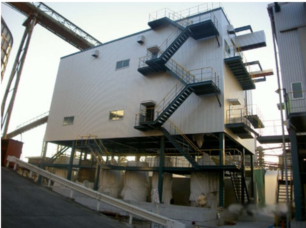
写真6 塩素バイパスダスト脱塩処理設備
