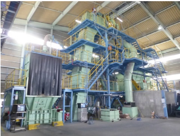
写真2 廃プラ処理設備
