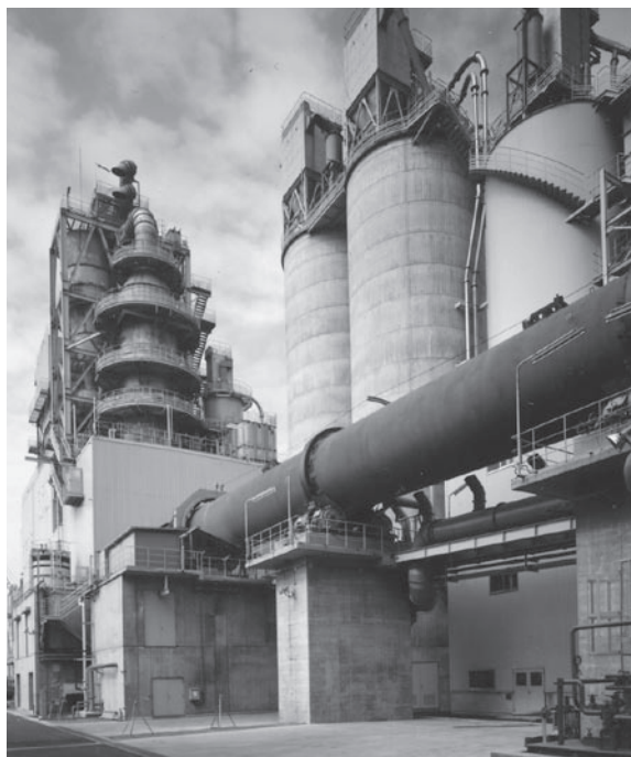
写真3 ロータリーキルンと排ガス冷却塔
