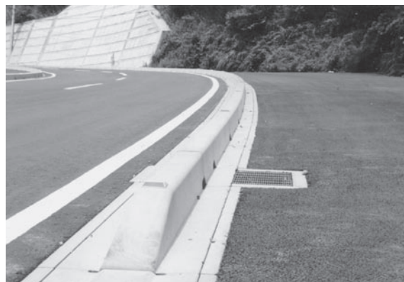
写真4 千葉県道に敷設されたバリアフリーブロック [エコセメントを使用したコンクリート製品の代表例]
