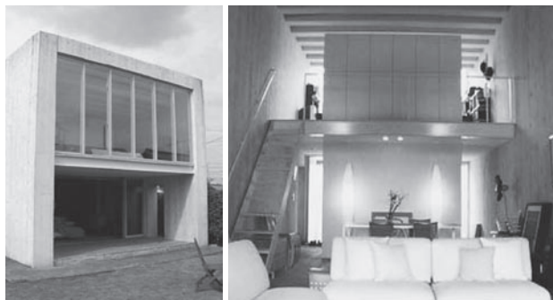
ホワイトコンクリートで施工した一般住宅 写真2 ホワイトセメントを使用した施工例
