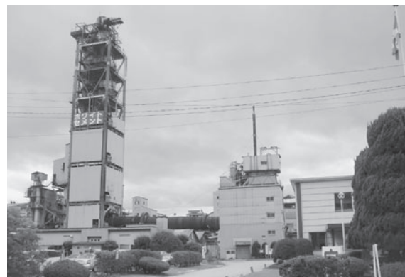
写真3 事務所棟(右)とNSPキルン
