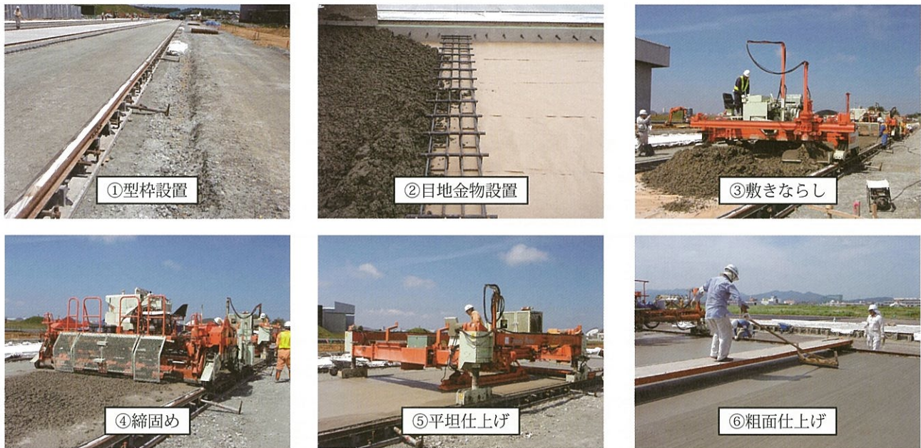
写真-1 セットフォーム工法による普通コンクリート舗装の舗設
