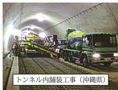
写真-1 連続鉄筋コンクリート舗装の施工状況
