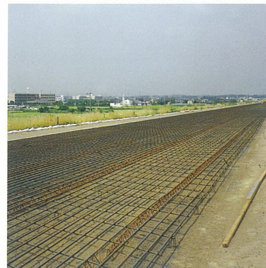
路盤上に配筋した鉄筋の状況
