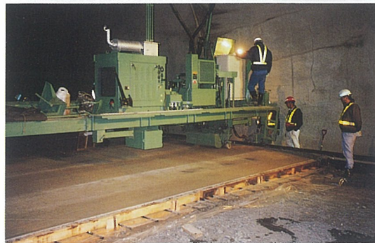
骨材露出機械(ワイヤブラシ装着)
