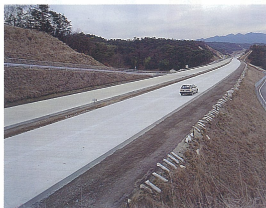
高速自動車のコンポジット舗装(アスコン施工前)
