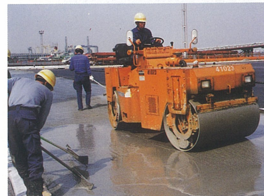
セメントミルクの母材アスファルト混合物への充填作業
