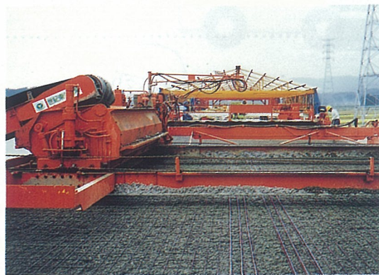
鉄網を入れた2層敷きならしによる施工状況
