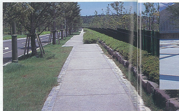
透水性コンクリート舗装
