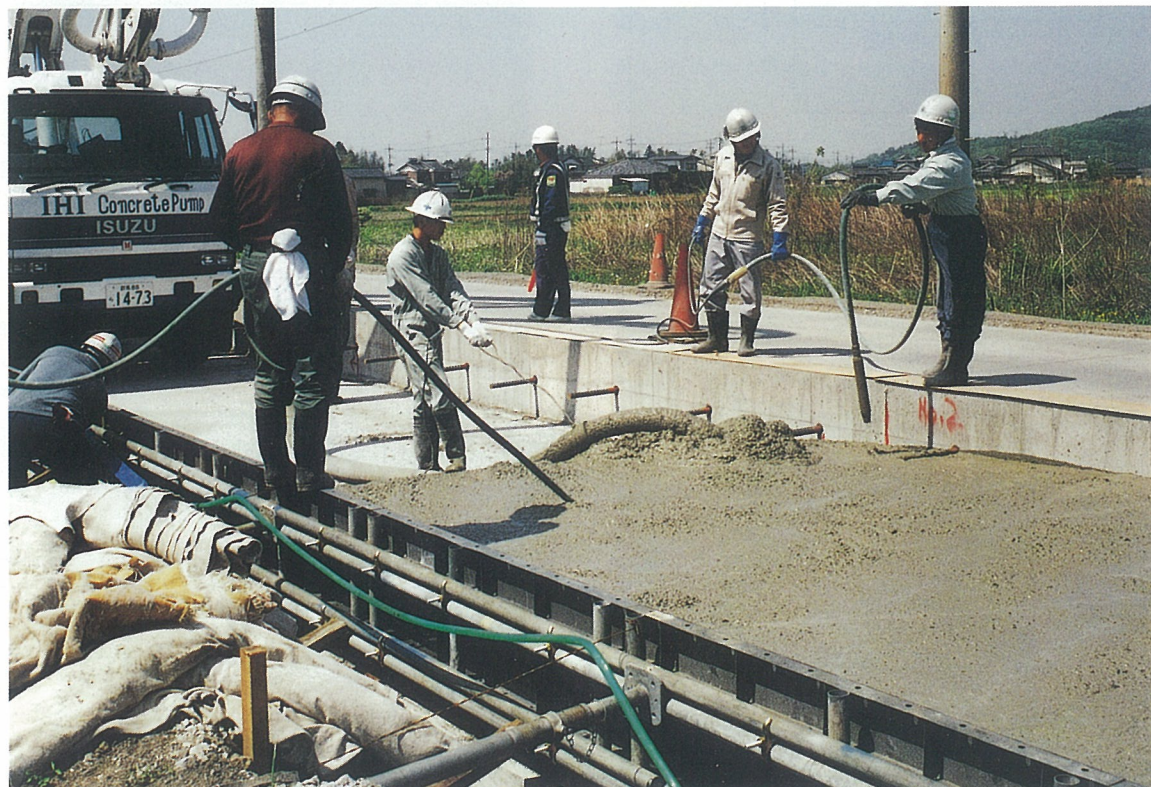
ポンプ打設による施工例
