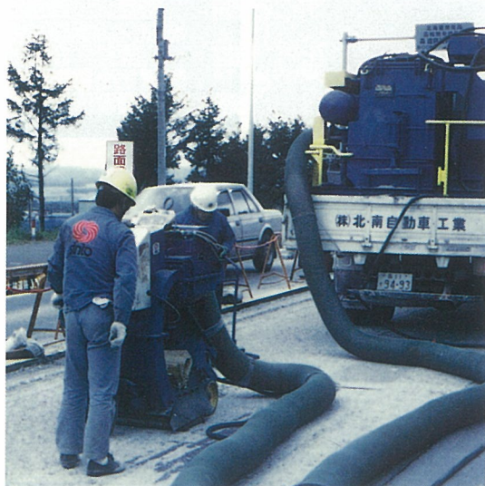
ショットブラストによる切削面の研掃作業
