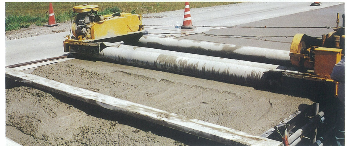
パイプフィニッシャーによる仕上げ状況
