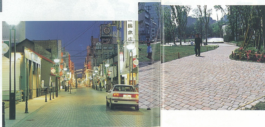
インターロッキングブロック舗装
