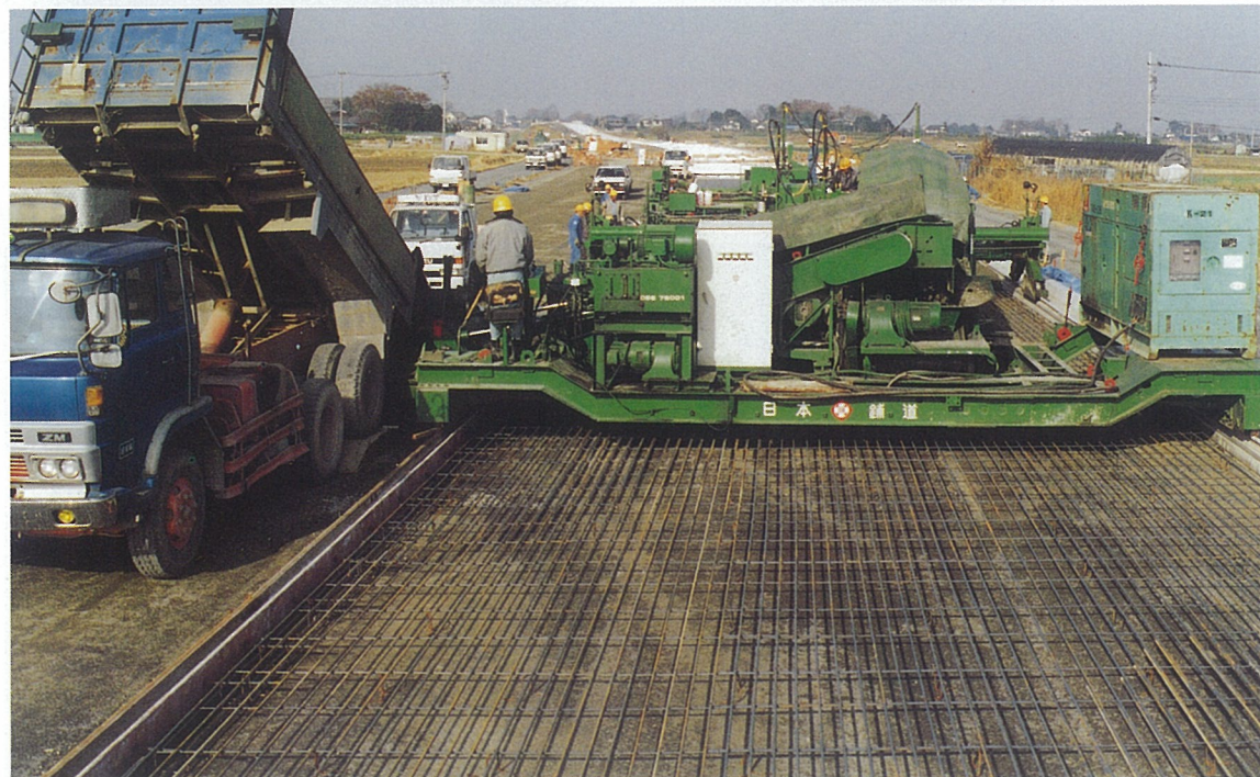
セットフォーム方式によるCRC版の舗設状況
