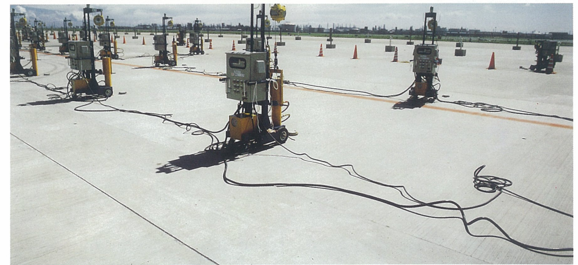
リフトアップ工法による不同沈下の不陸修正
