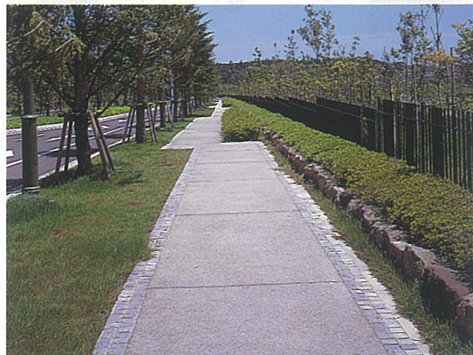
歩道での施工例
