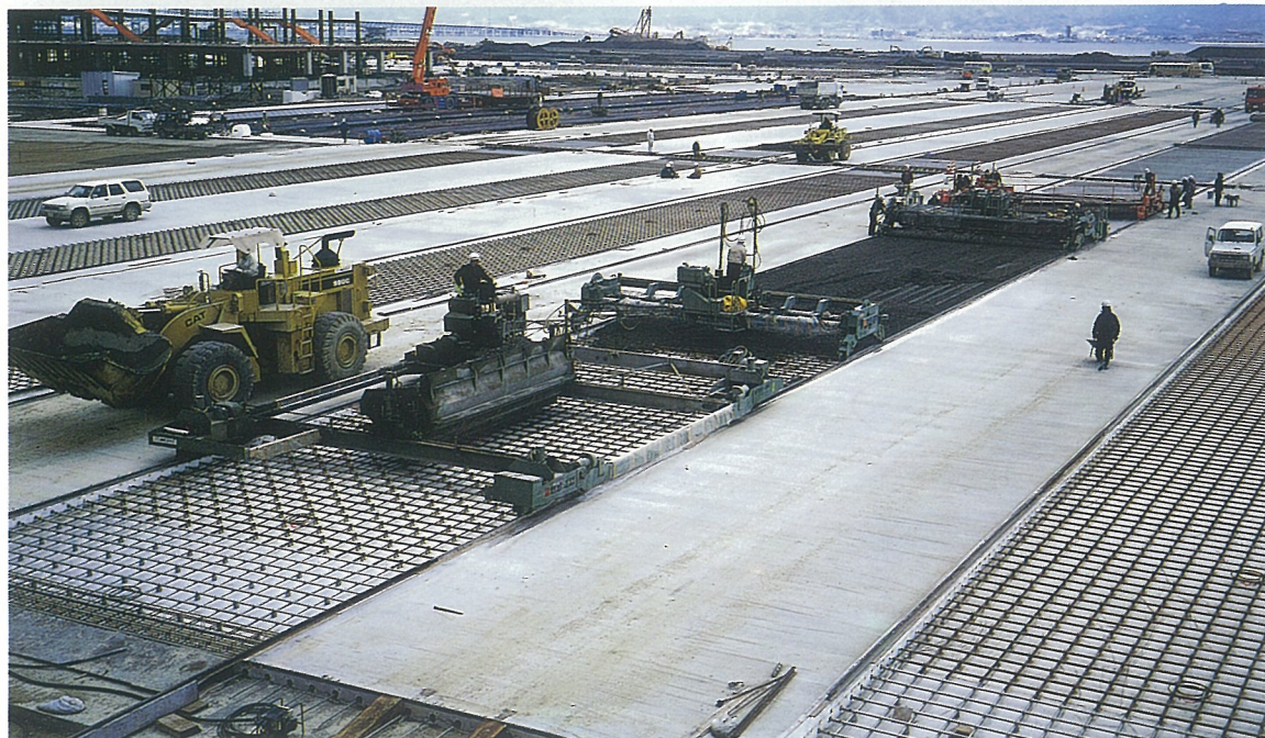
コンクリート打設
