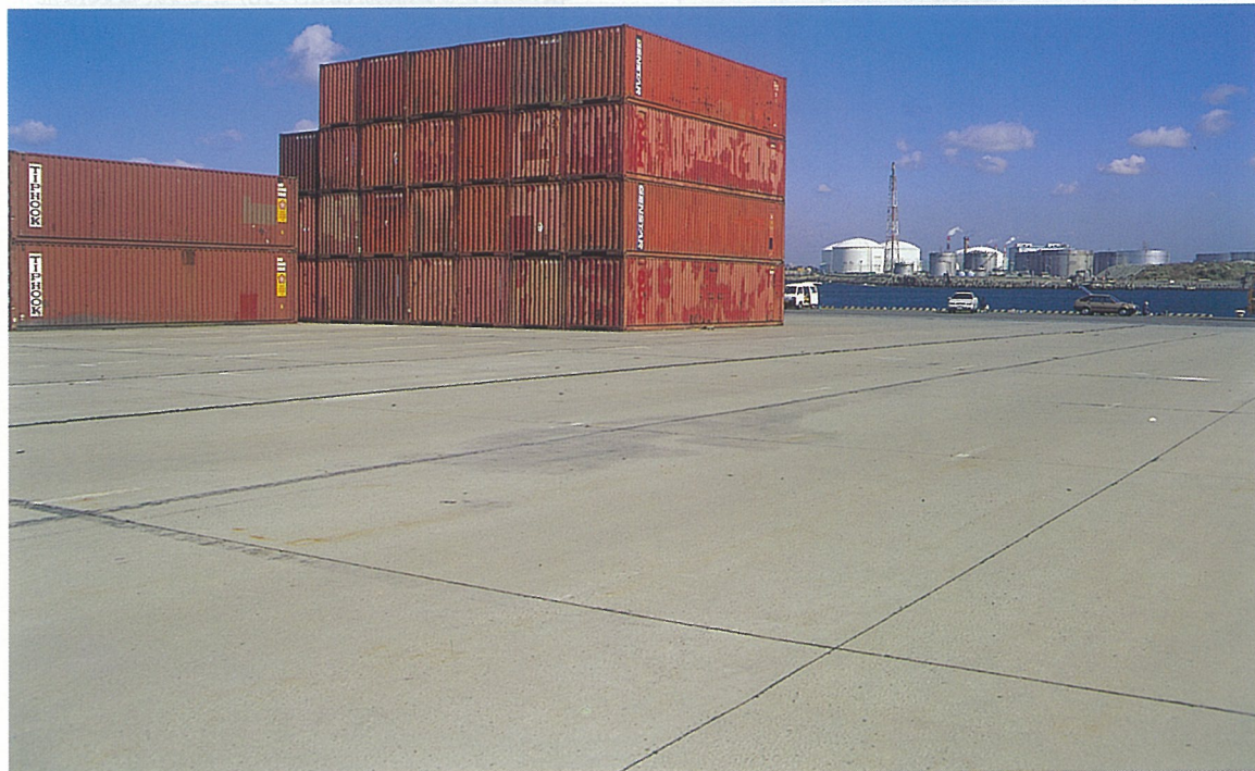
港湾コンテナヤードにおける供用状況
