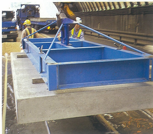
積雪寒冷地域のトンネル内舗装修繕工事でのRC版
