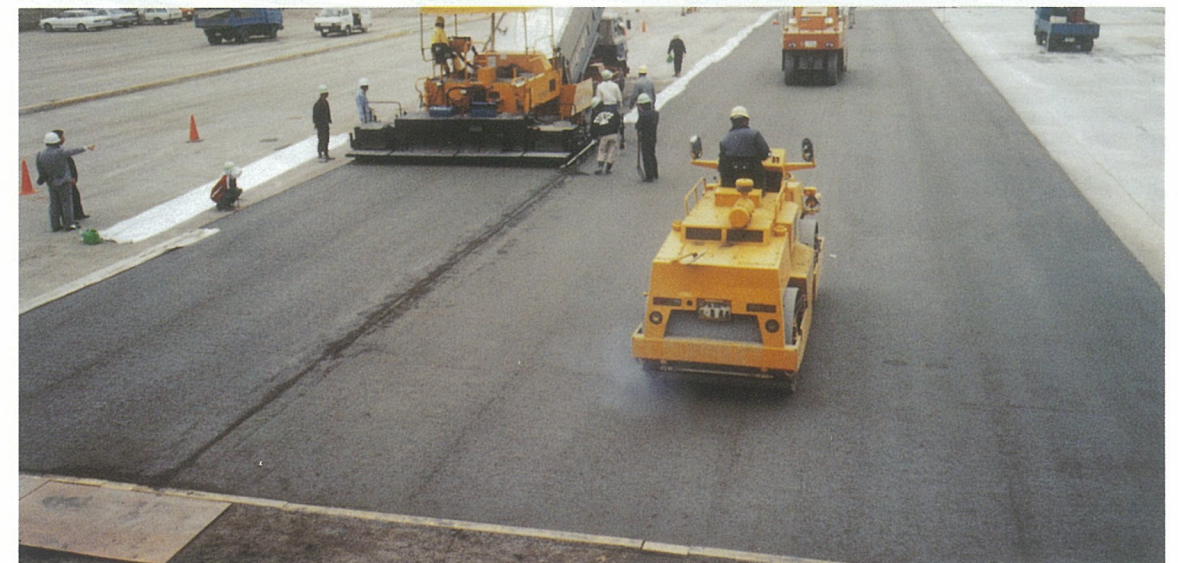
型枠を用いずフレッシュジョイント工法を採用したヤード舗装の舗設状況
