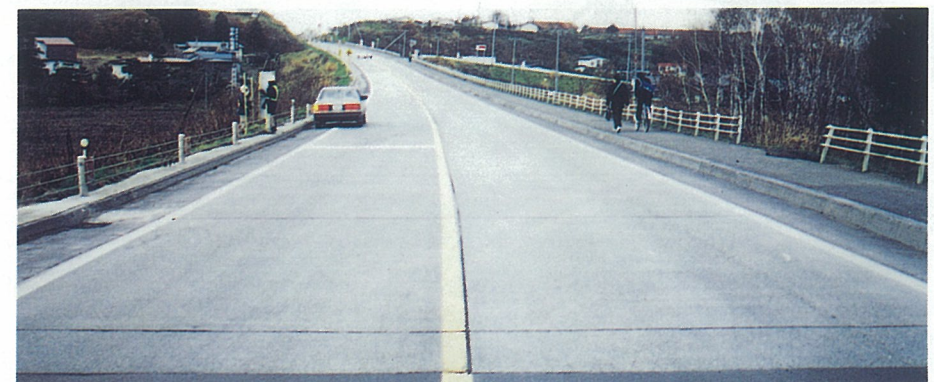
施工が完了した薄層コンクリートオーバーレイ
