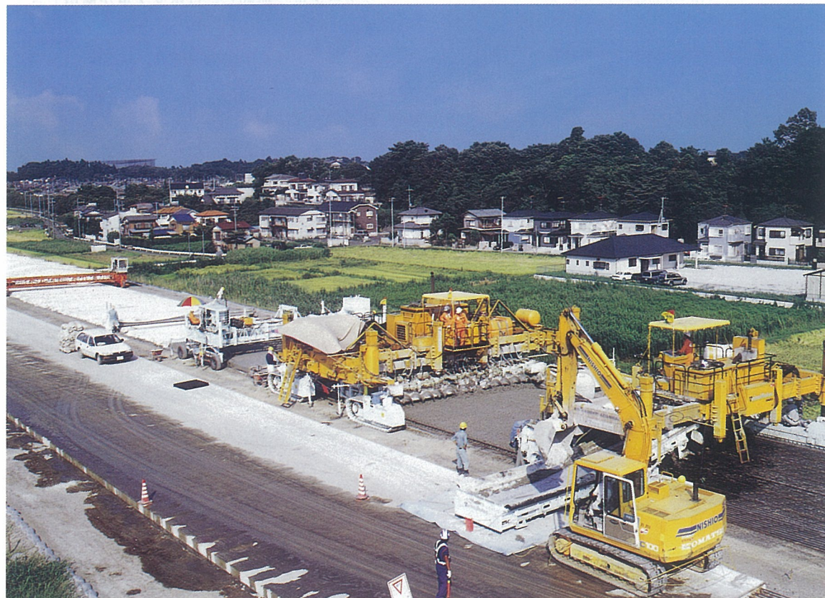
スリップフォーム工法による施工の全景
