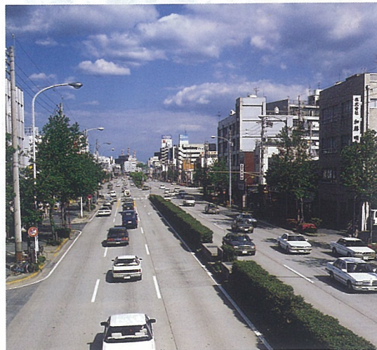
CRCPの供用状況
