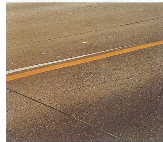
あらかじめアスコン層に設けた目地
