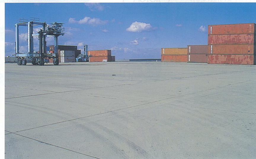
転圧コンクリート舗装(RCCP)
