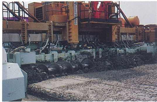
スリップフォームペーバによる施工状況
