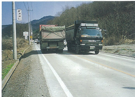
町道での供用状況
