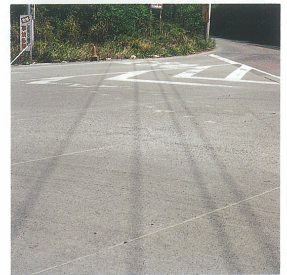
重交通道路交差点のわだち掘れ対策としてPC版で補修
