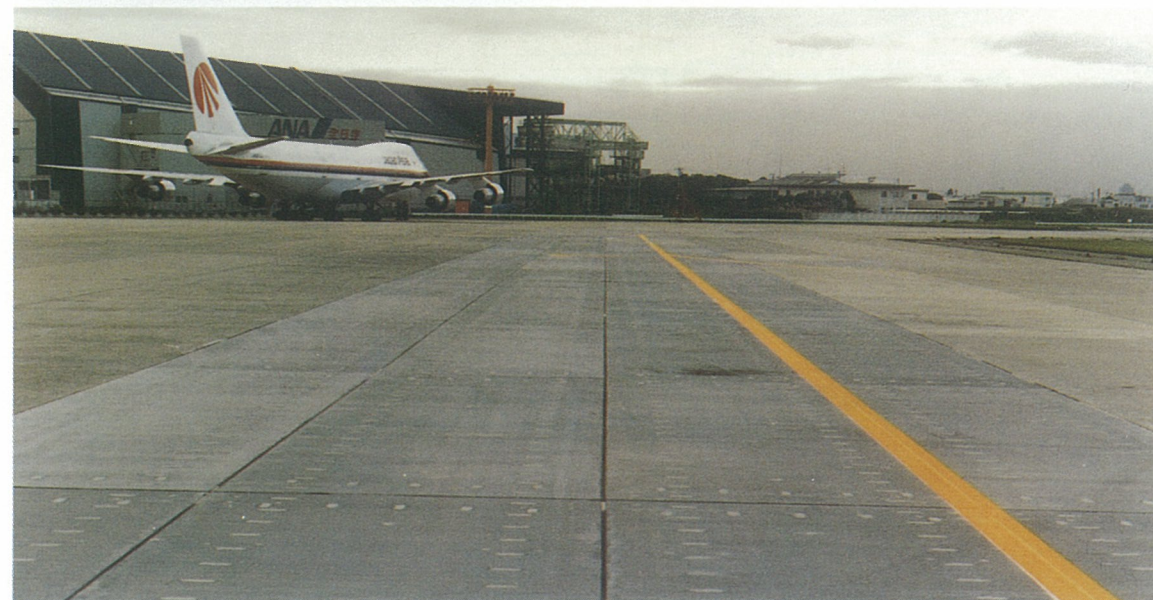
空港エプロンの夜間打換えにPC版を採用
