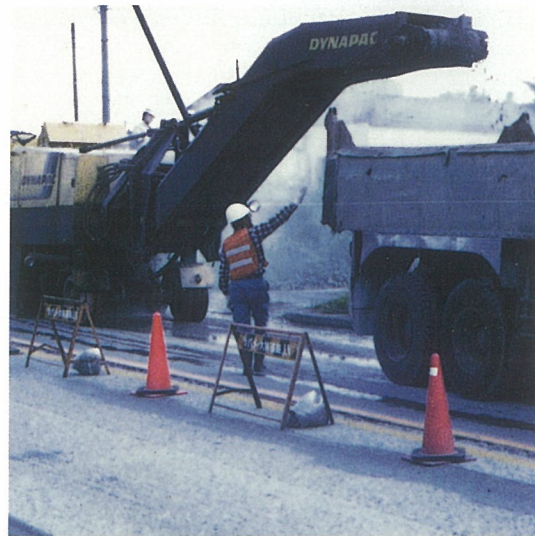
既設コンクリート版の切削作業
