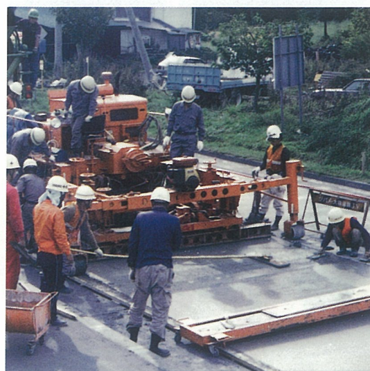
コンクリートの敷ならし仕上げ作業
