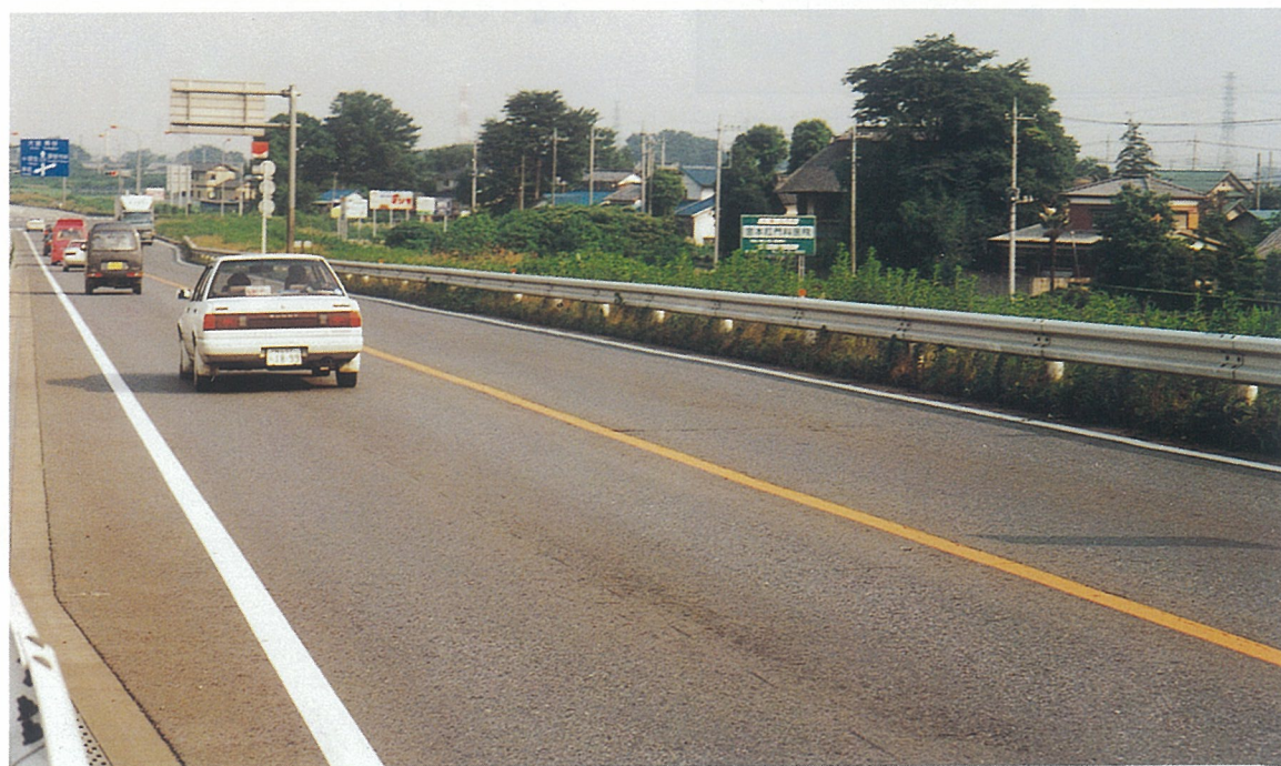
国道バイパスにおけるRCCPをベースとしたコンポジット舗装の供用状況
