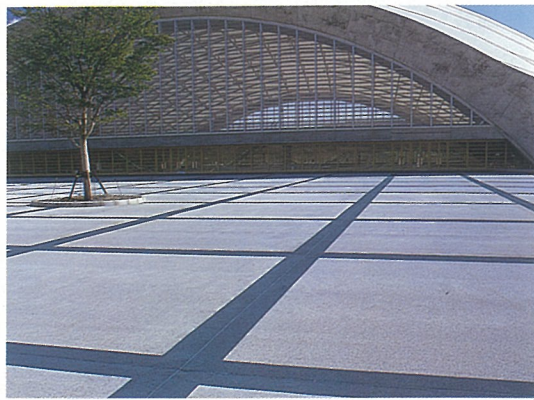
広場での施工例
