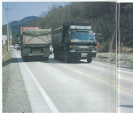
フルデプスコンクリート舗装(FDCP)
