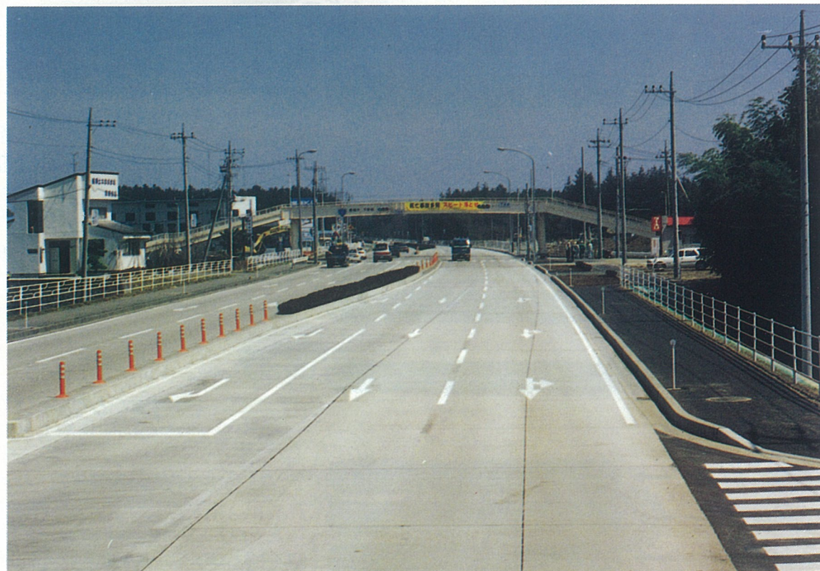
国道バイパスにおける供用状況
