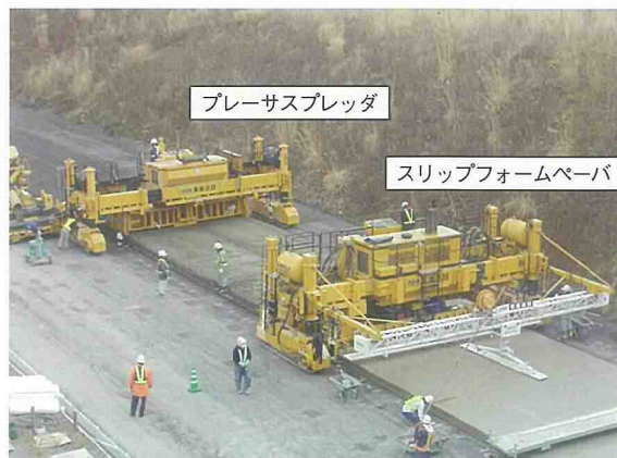
写真1 大型機の施工状況
