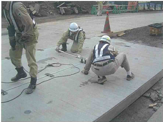
写真11 シグナル付トルクレンチによる締付け
