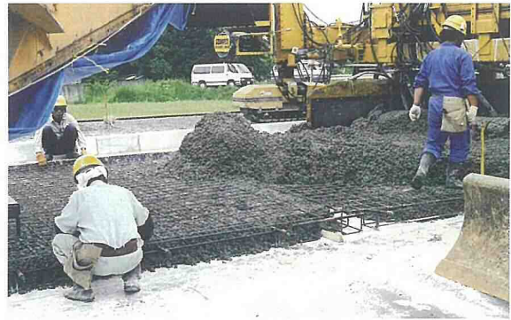
写真1 スリップフォーム方式による舗装 —鉄網は施工のネックになる
