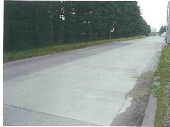
写真3 工場構内道路 舗設後の近況
