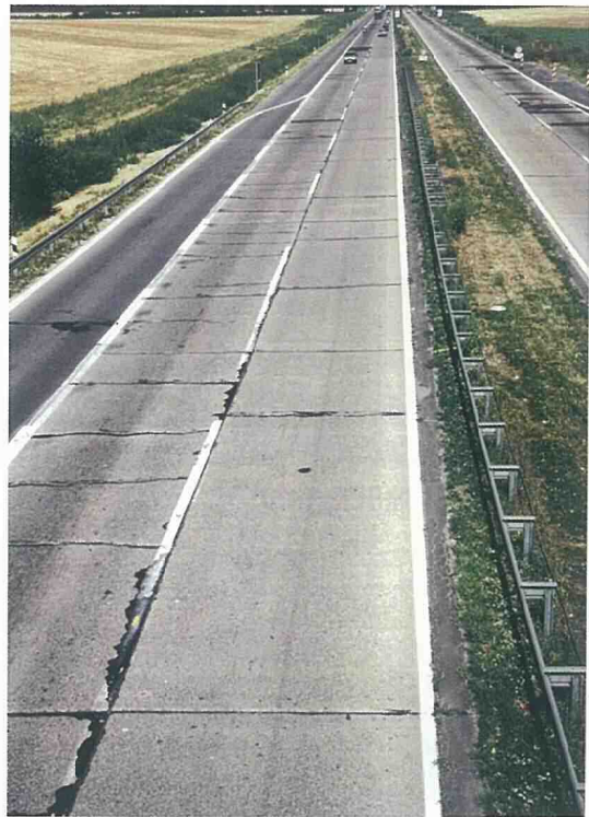
写真11 旧東ドイツのアウトバーンのコンクリート舗装(松野三郎氏提供) 3)
