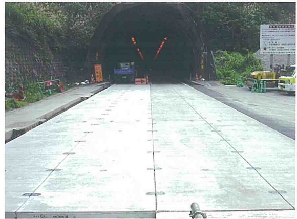
写真12 高強度PRC版施工完了状況
