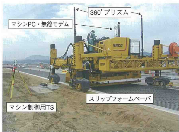
写真3 自動追尾式TSシステムの適用状況
