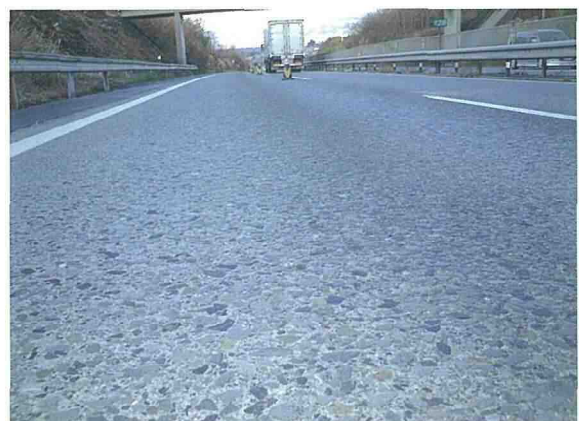
写真1 供用から約30年経過した中央自動車道のコンクリート舗装
