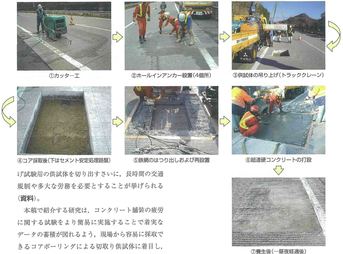
資料 高速道路での疲労試験用供試体採取作業の流れ
