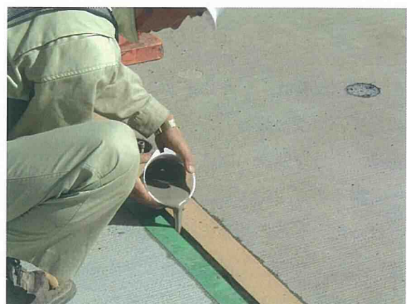
写真10 目地グラウトの注入
