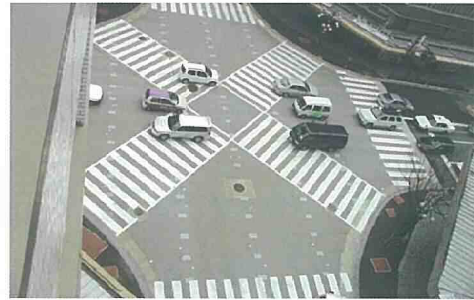
写真2 プレキャストコンクリート舗装が舗設された交差点(金沢市)
