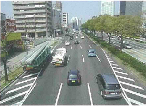
写真2 RCCPコンポジット舗装での供用状況 (国道19号)
