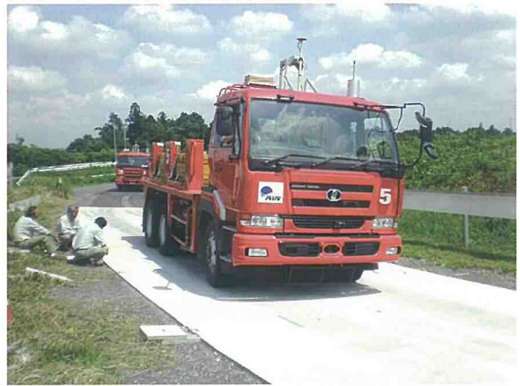
写真2 走行試験路におけるコンクリート舗装区間
