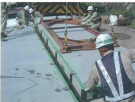
写真7 PRC版の敷設
