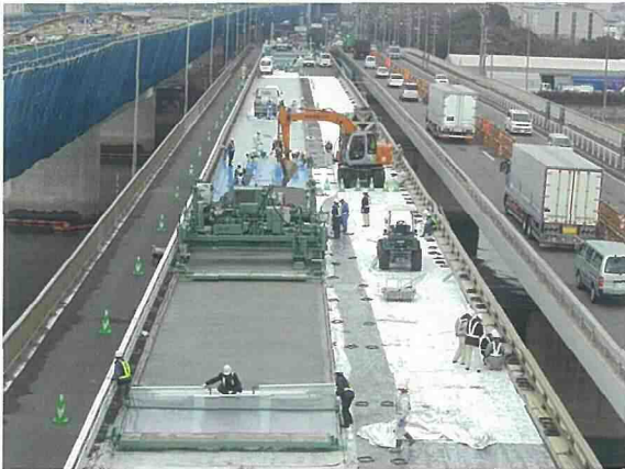
写真1 鋼床版SFRC舗装の施工事例
