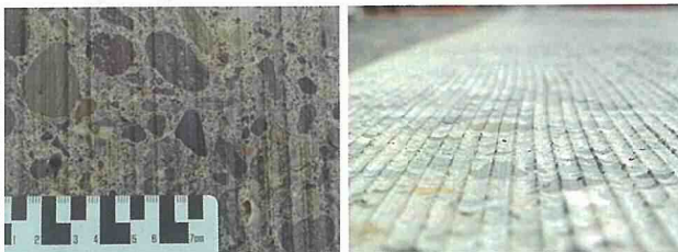
写真5 施工後のコンクリート舗装
