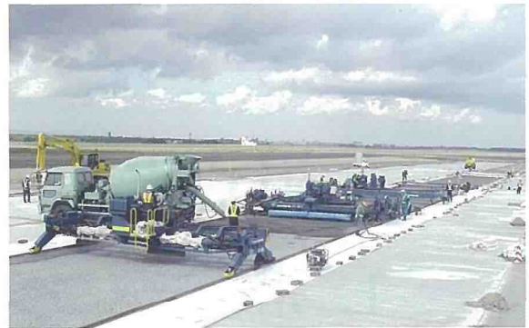
写真3 空港での付着型コンクリートオーバーレイ
