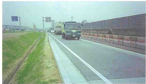
写真2 車道用ポーラスコンクリート舗装
