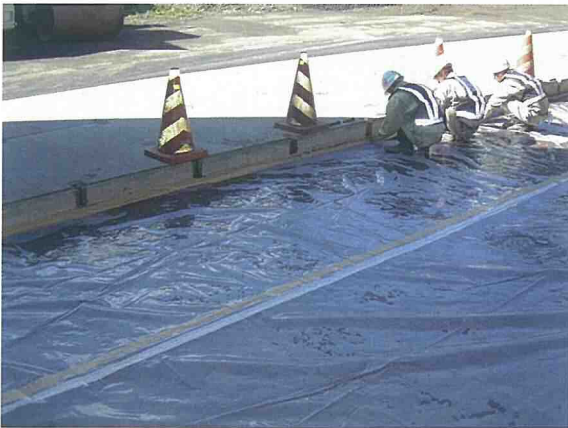
写真6 ビニールシートの敷設
