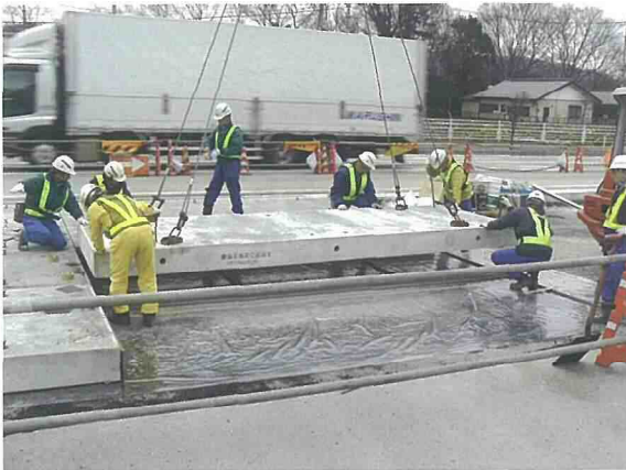
写真2 道路でのプレキャストRC版の施工例
