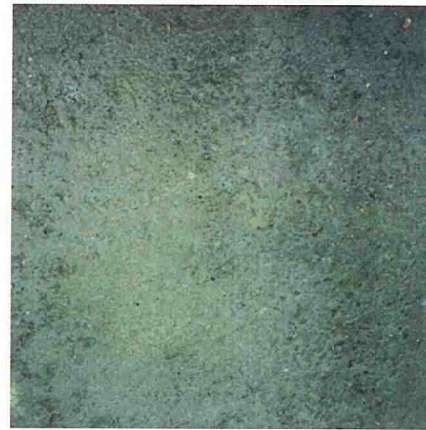
写真2 完成路面状況
