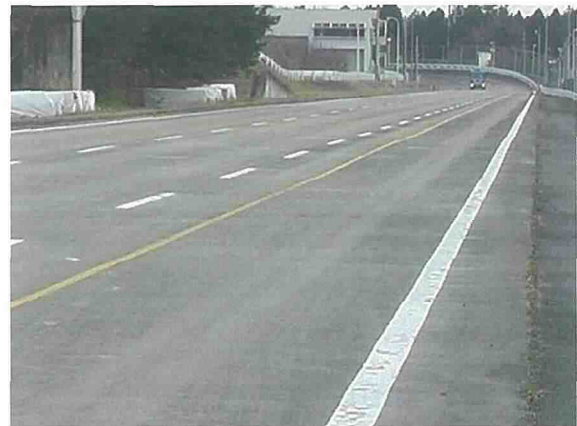
写真2 国総研での走行抵抗試験状況 (舗装D, 往路直線部コンクリート舗装)
