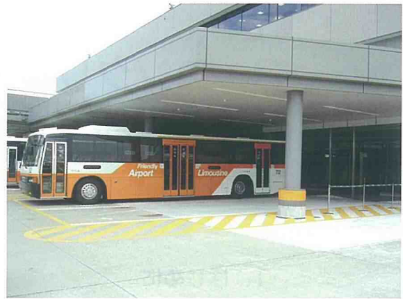
写真4 試験舗装後の供用状態
