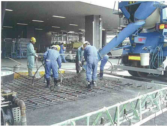
写真3 試験舗装の施工風景
