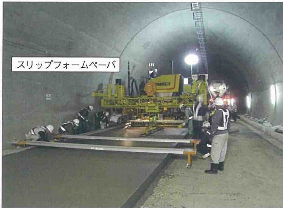
写真2 2車線分割施工の施工状況
