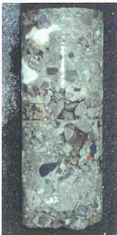
写真4 接着不良個所のコア
