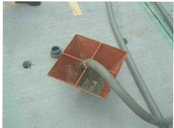
写真9 裏込めグラウトの注入
