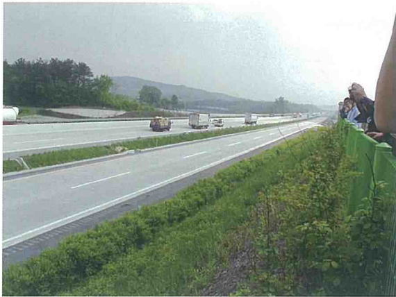
写真18 韓国的高速道路における試験舗装区間
