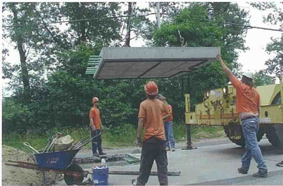
写真6 アメリカのプレキャストコンクリート舗装
