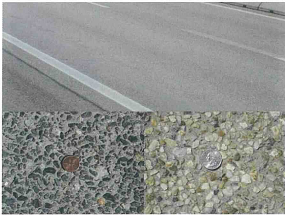
写真12 骨材露出工法によるコンクリート路面
