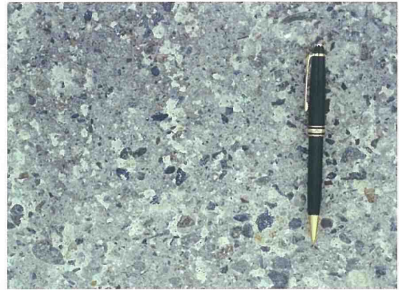
写真5 施工18年後の路面
