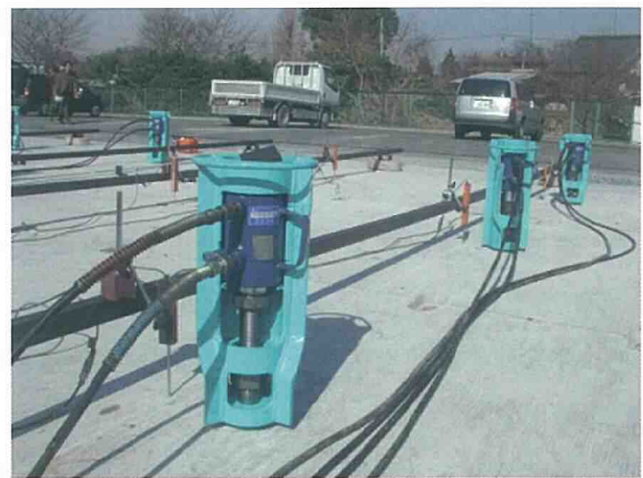
写真5 油圧ジャッキの装着
