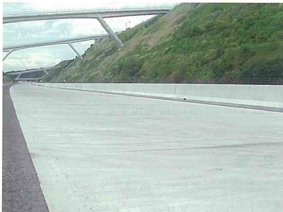
写真1 連続鉄筋コンクリート版の施工状況
