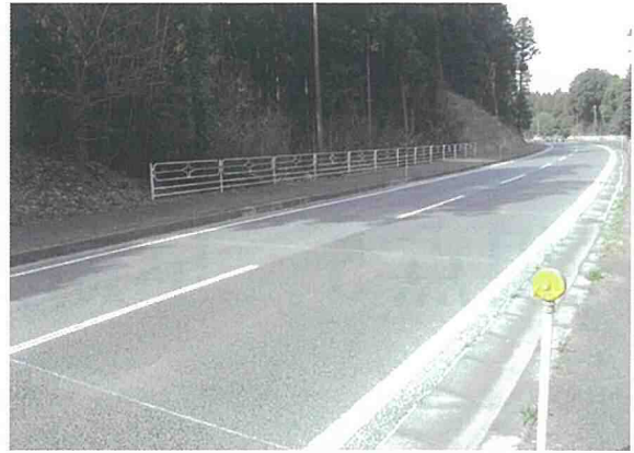
写真3 RCCP・ポラコン複合版舗装での供用状況 (千葉県)
