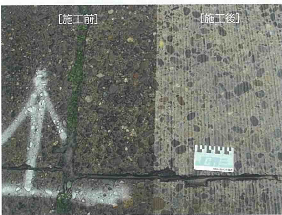
写真4 施工前後の表面の様子
