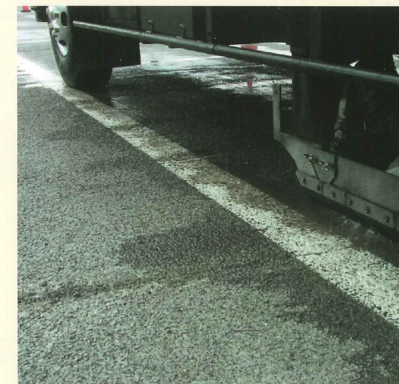
機能回復処理後の路面
