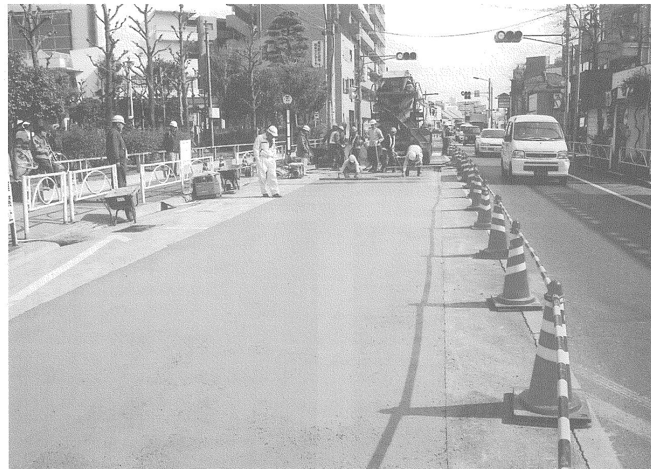
▼写真5 コンクリートの打設〈2〉 3月13日・土曜日の昼さりの工事。写真のように交通量も少なくない。No.3は最後の現場ということもあり、作業員も工事に慣れてきていた。
