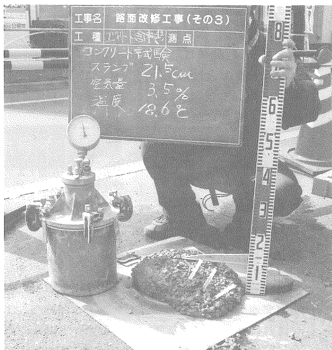
▲写真3 打設コンクリートのスランプと空気量 写真のスランプは、塩分測定のため多少かたがたくずれている。
