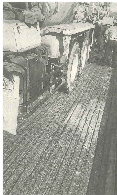
Q25・写真2 SFRCオーバーレイ施工部切削面（国道4号・黒磯バイパス）
