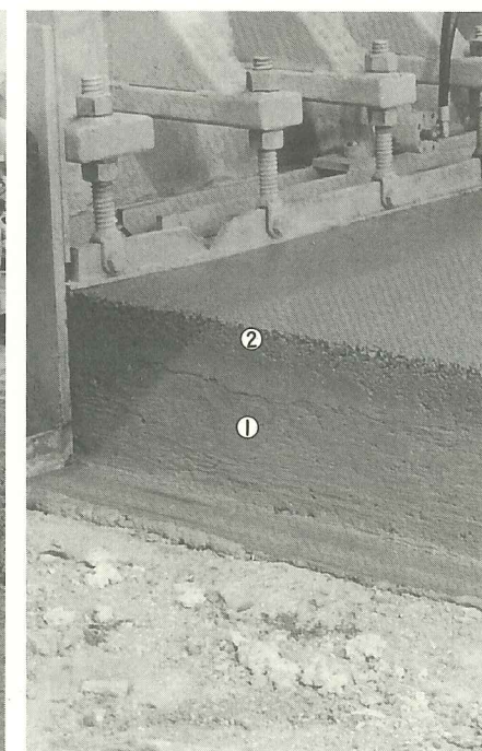
Q19・写真2 舗設後のCRCP
