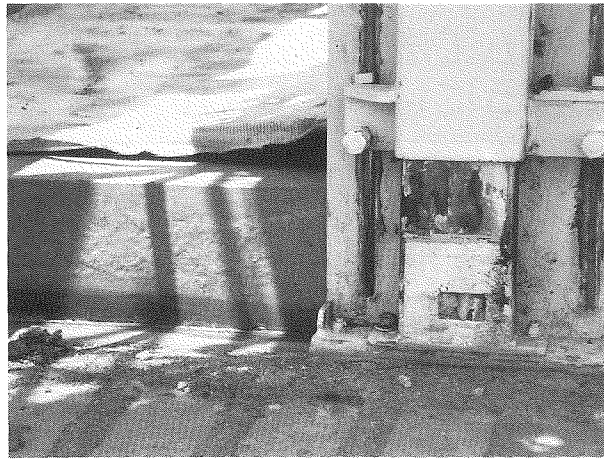
Q15-写真1 自立性の高いコンクリート
