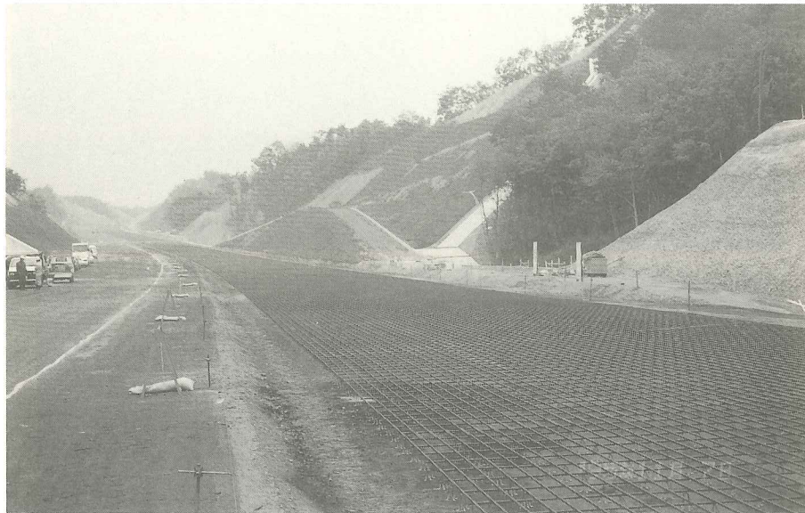
Q17・写真2 鉄筋施工状況（山陽自動車道）
