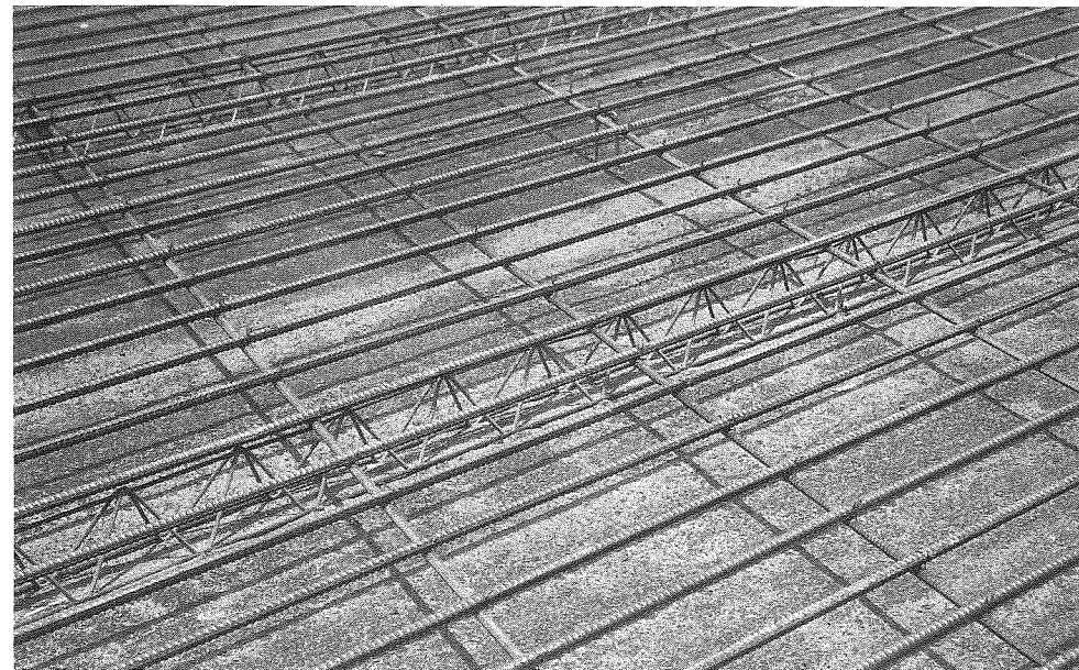
Q14・写真1 連続スペーサの例（館山自動車道）
