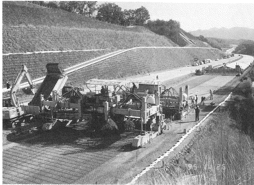
Q16・写真1 スリップフォーム工法の施工全景（山陽自動車道）
