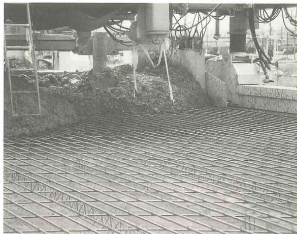
・コンクリートの敷均し
