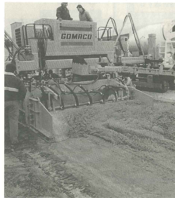
Q19・写真1 2層同時施工のスリップフォームペーバ
