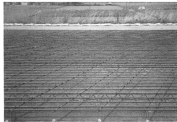
Q13・写真1 鉄筋の設置状況 (館山自動車道)
