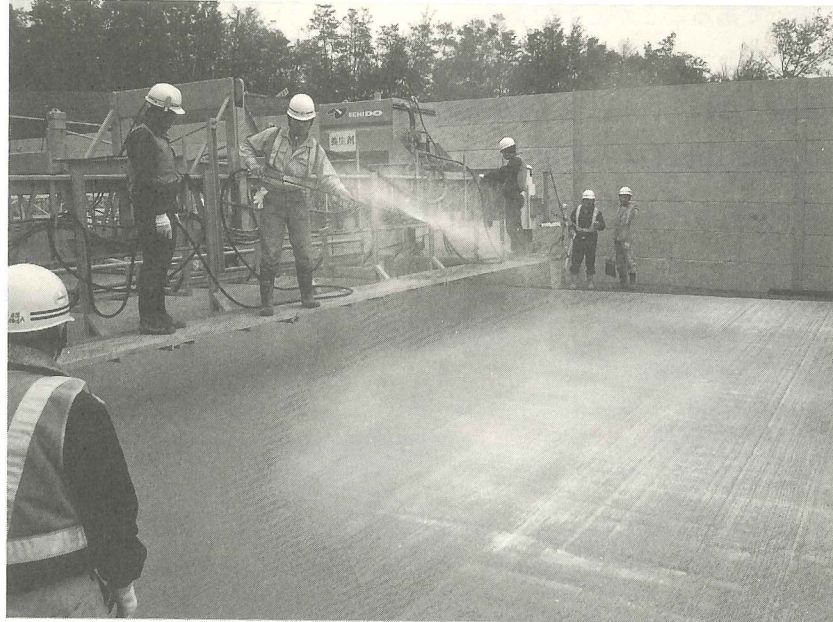
Q17・写真5 膜養生剤の散布（山陽自動車道）
