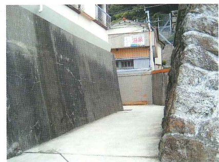
静岡県南伊豆町 (狭小部)
