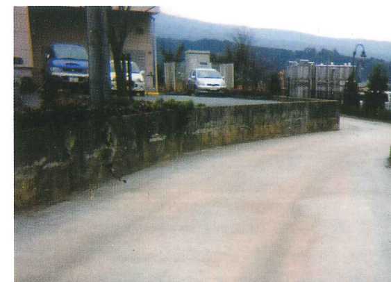
静岡県裾野市 (構内舗装)
