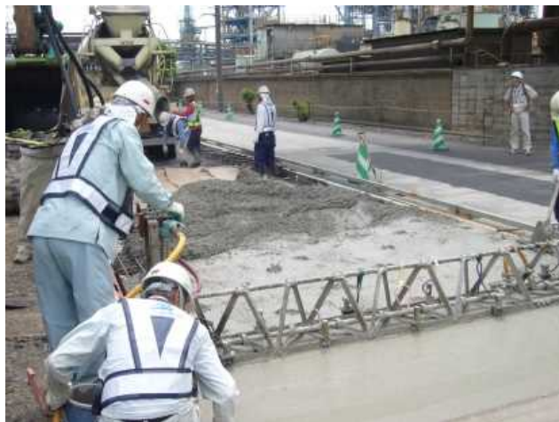
簡易フィニッシャによる施工事例
