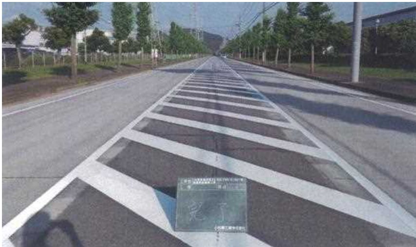
中央帯部分はアスファルト舗装のまま
