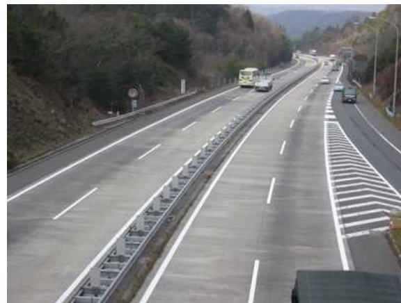
山陽自動車道 岡山県備前市※2 (連続鉄筋コンクリート舗装)
