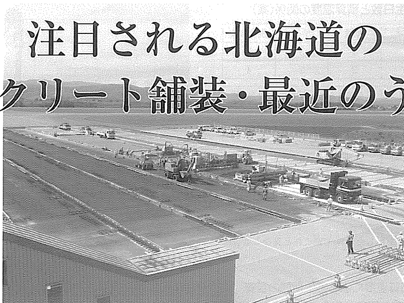
空港のエプロン舗装(旭川)
