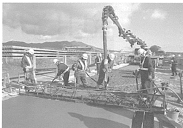
写真3 コンクリートポンプ施工例(登別)
