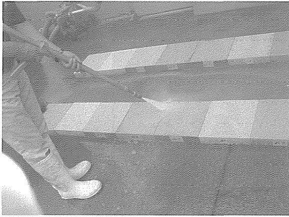
写真1 高圧水による洗浄実験
