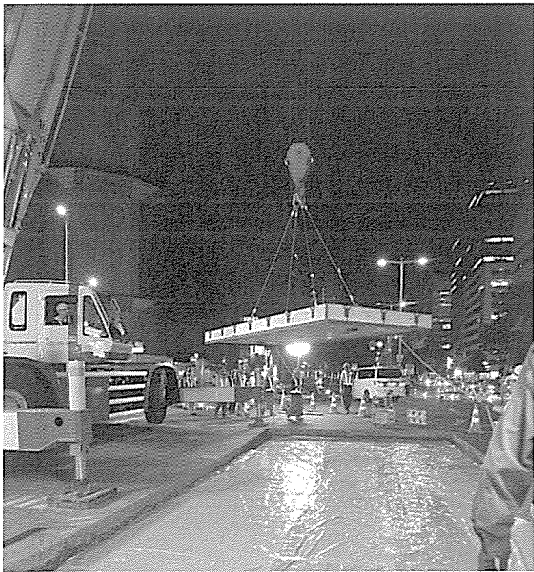
50tクレーンで吊り上げて移動。市の中心部で夜間でも車の通行が絶えないなか、当日は4枚のPRC版設置が行われた。
