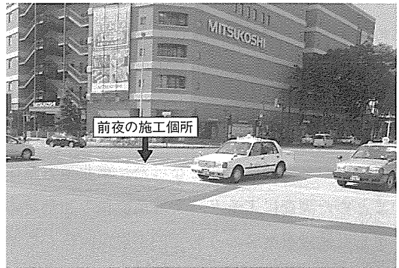
施工翌日の現場。次はこの手前の部分が施工され、順次進んでいく。
