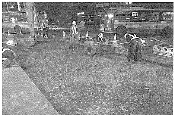
地盤の均し工はPRC版設置に影響を与えるため丹念に行われる
