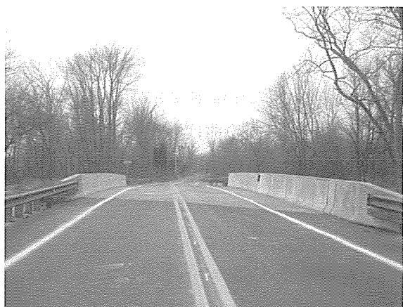
写真2 短い橋梁の床版との一体打ちの例
