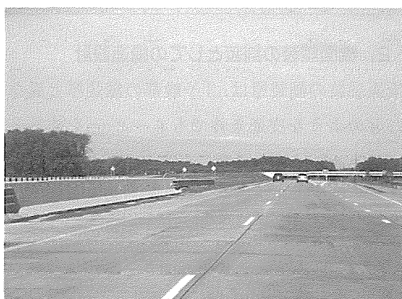
写真1 インターステートハイウェイの橋面舗装 [Wikipedia, file Typical USA concrete Bridge Deckより]
