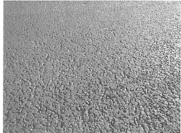
ポーラスコンクリート舗装の表面状況 [提供：阪神高速道路㈱]
