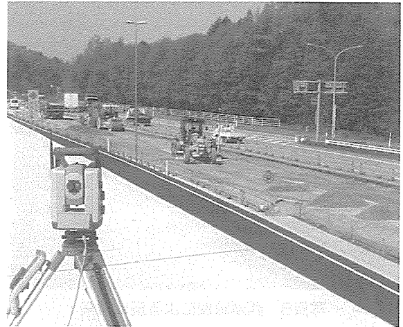
写真6 MCによる路盤施工状況
