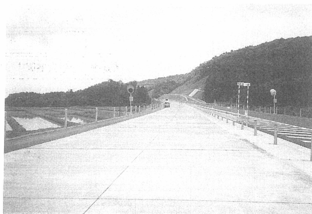
写真2 明かり部の試験施工区間の全景
