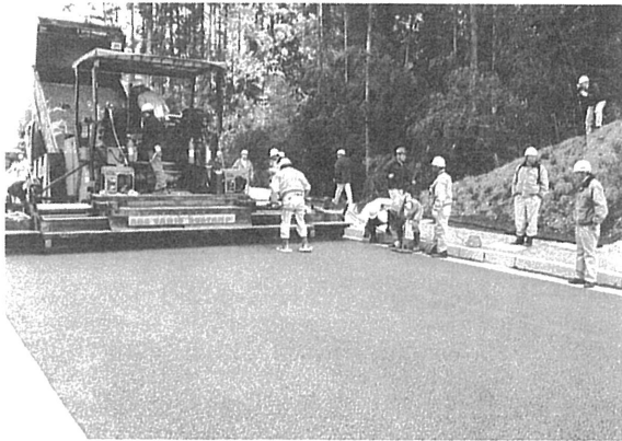
写真1 千葉県での排水性ポーラスコンクリート舗装工事
