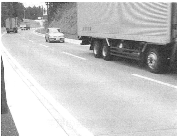
写真1 試験舗装の施工場所の状況
