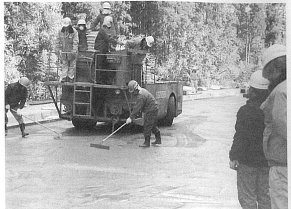
写真3 付着材塗布(bタイプ)
