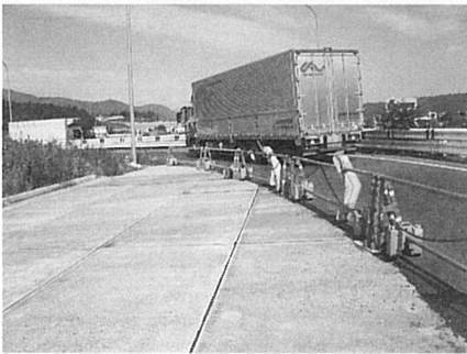
写真11 国道353号への流出部
