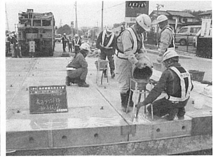
写真7 裏込めグラウト材の注入
