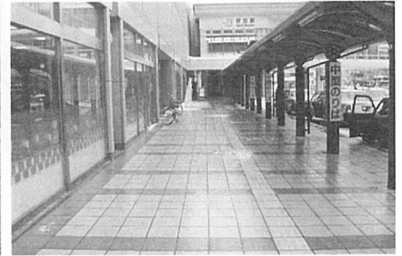
写真17 表面にタイルを貼った秋田駅ビル前の融雪版の稼働状況
