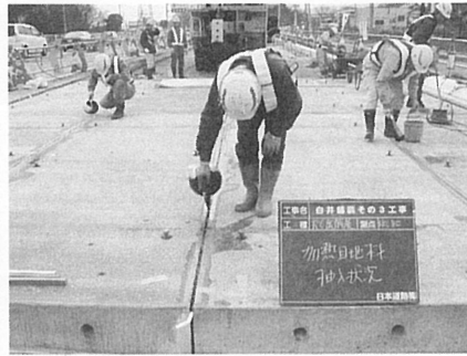
写真6 加熱目地材の注入
