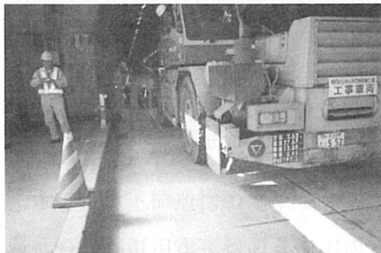
写真15 朝日トンネルの載荷試験状況
