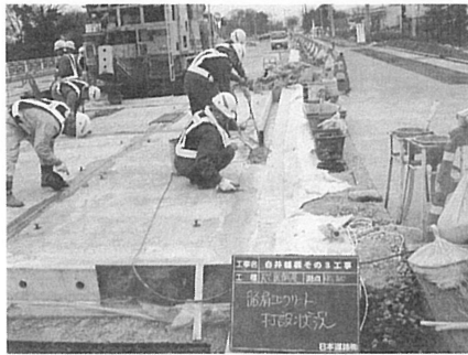
写真5 路肩コンクリート打設
