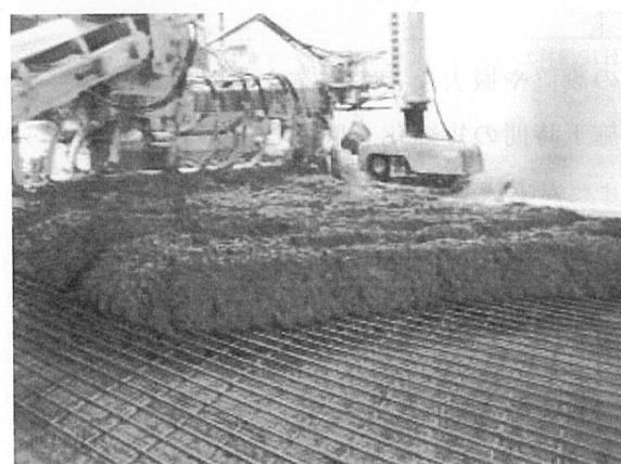
写真2 生コンの敷き均し状況
