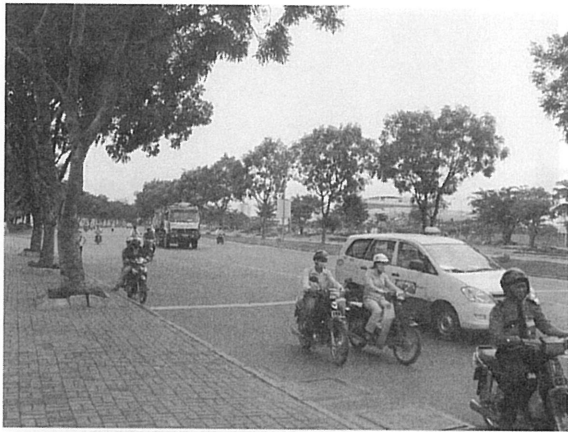
写真6 開発地区の整備された道路
