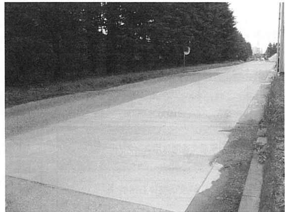
写真4 半年後の構内試験施工現場
