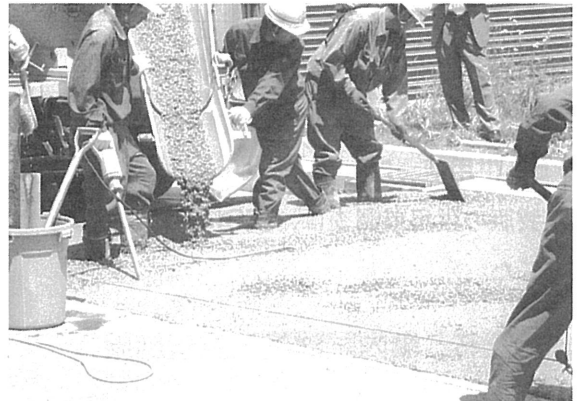
写真2 早期開放型コンクリートの舗設
