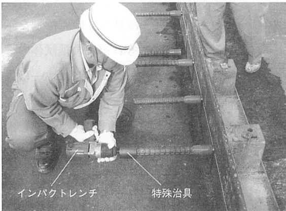
写真5 インパクトレンチによる取り付け状況
