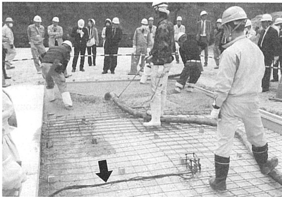
写真2 手前のコードがひずみ計のセンサーケーブル (神戸市)
