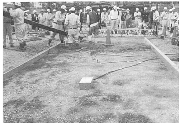
写真3 ひび割れ照査用のセンサーケーブル(大阪市)
