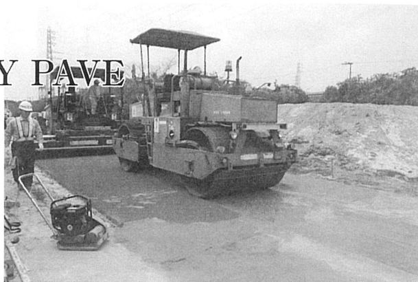
袖ヶ浦市でのRCCP施工 振動ローラによる初期転圧
