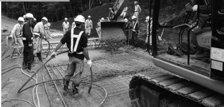
勾配個所でのコンクリート打設／山口
