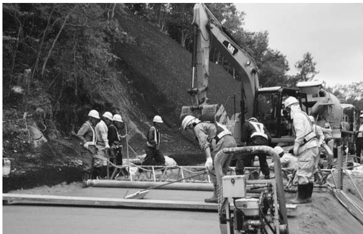
順次進む仕上げの様子
