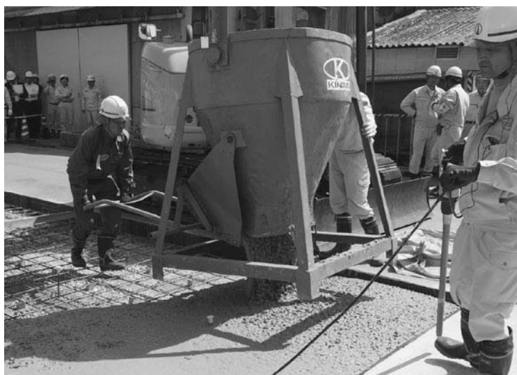
写真2 排出後は高周波バイブレーターとコテ仕上げのみの省力化施工にチャレンジ
