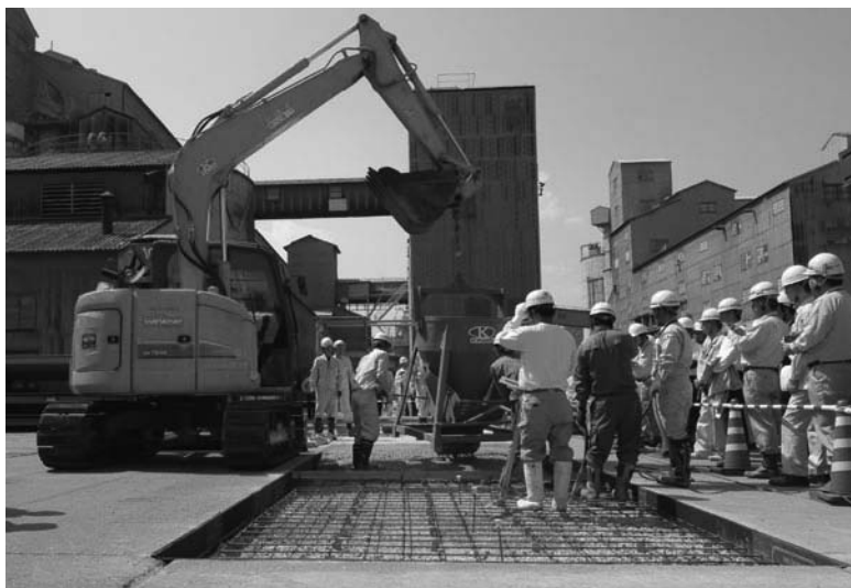
バックホウでホッパを吊上げ、施工個所に排出 ／岐阜
