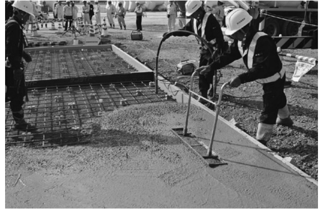
写真8 締固めは高周波バイブレータとタンピングプレートにより簡易な施工にチャレンジ
