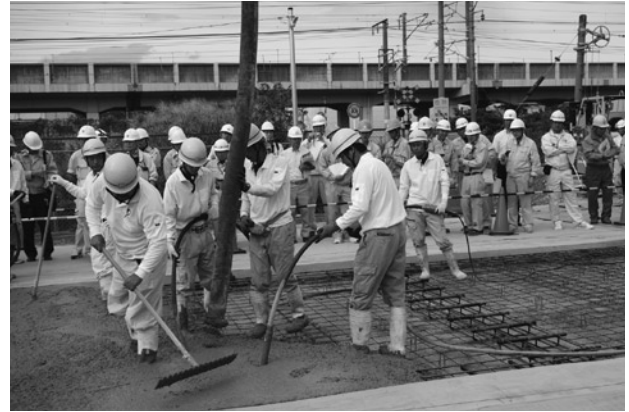
写真4 施工面積1258m 2 は過去最大。ダウエルバー、タイバー入りの本格仕様が注目を集めた
