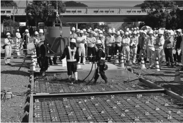
写真7 ホッパでの排出。ホッパ後方で見学者が立つコンクリート版は前日施工箇所
