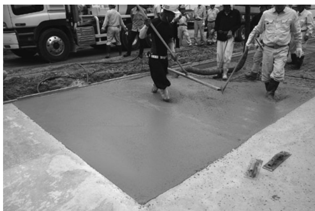
写真1 W/C40%、早強配合のエリア、W/C35%に比べ施工性は高い
