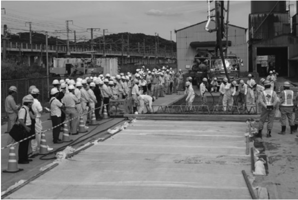
写真3 手前の白シートは当日午前中の打設箇所、青シートは9月5, 13日の既打設箇所
