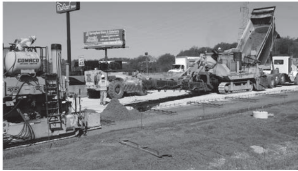
写真1 下層の舗装状況
