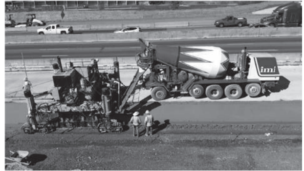
写真2 上層の舗装状況
