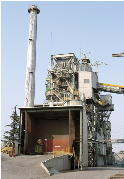
写真2 自家発電装置(奥)と木くず投入設備
